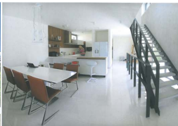
Jednoramenné ocelové schodiště s betonovými stupni spojuje obě podlaží. Díky konstrukci bez podpěrnic zůstává zachován otevřený ráz prostoru.
